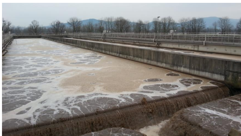
Slika 68: Prezračevalni bazen s suspendirano biomaso (mikroorganizmi)
