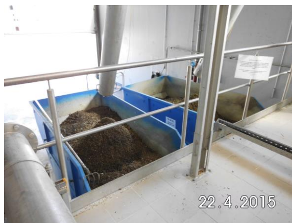
Slika 64: Odpadki, odstranjeni na mehanski stopnji čiščenja – ozračeni lovilce maščob in peskolov. Vir: Lasten
