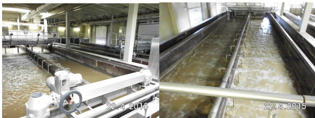
Slika 33: Ozračeni lovilce maščob in peskolov Vir: Lasten
