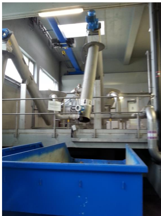
Slika 63: Sistem cevi za odstranjevanje mehanskih delcev iz peskolova Vir: Lasten
