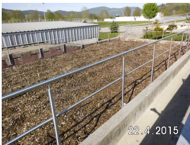
Slika 51: Biofilter na CČNL za čiščenje zraka Vir: Lasten
