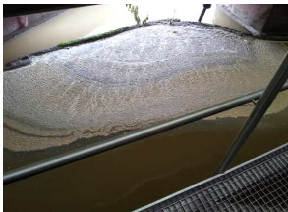
Slika 67: Odpadna voda na iztoku iz objekta za mehansko čiščenje – pred plavajočo oviro, i zadržuje snovi na gladini vode
