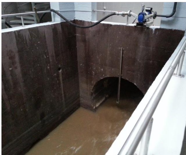
Slika 54: Poglobljena kineta za odstranjevanje mehanskih delcev, ki so težji od vode
