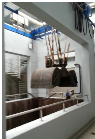
Slika 55: Grabilec kamenja v prvem objektu mehanskega čiščenja
