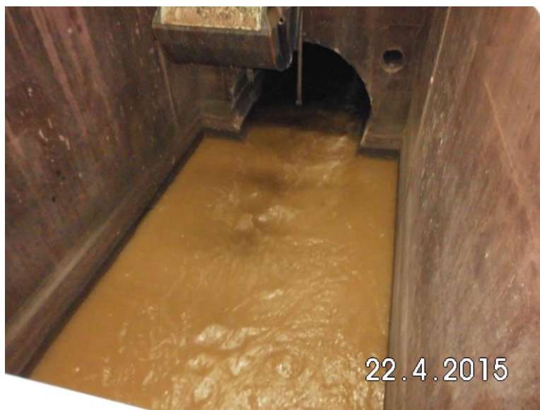
Slika 28: Kineta za lovilec kamenja – mehanska stopnja čiščenja Vir: Lasten
