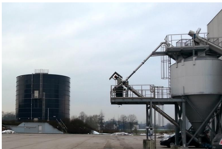
Slika 72: Plinohran za skladiščenje bioplina
