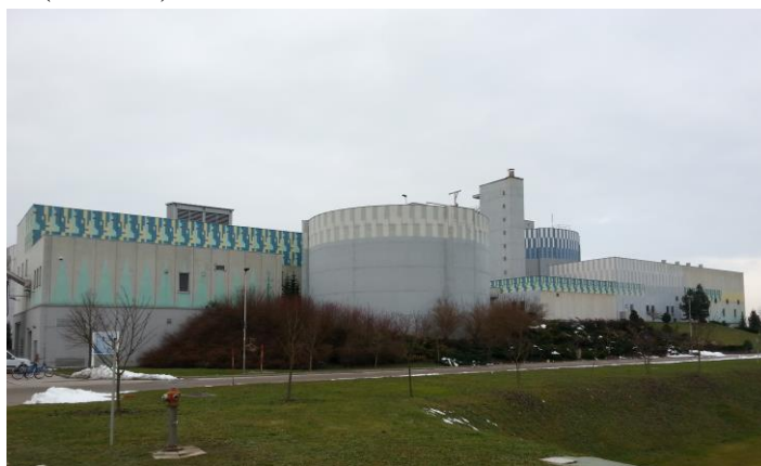
Slika 73: Objekti za obdelavo odvečne biomase iz procesa biološkega čiščenja
